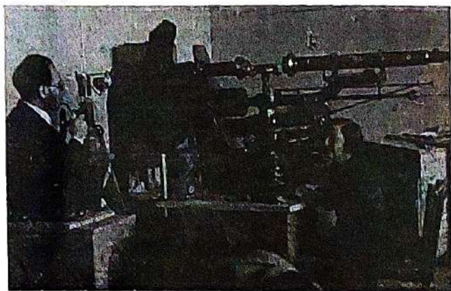
1944 год. Йошкар-Ола. Испытательный стенд по проверке качества аэрофотообъективов в оптотехнической лаборатории. На снимке – Д.С. Волосов и Н.П. Смирнова-Натансон.
